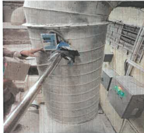
人造石生产线废气排放口 1#
